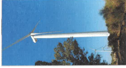
Figure 122 : Parc éolien de Beaucaire (Source : ARCA2E, 10 juillet 2019)
